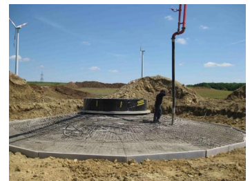
Støbning af fundament ved Eisenach II
