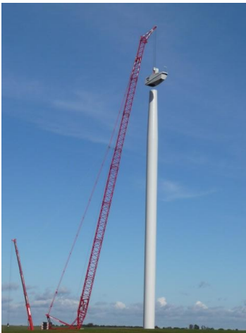
Rejsning af REpower mølle i Pinnow.
