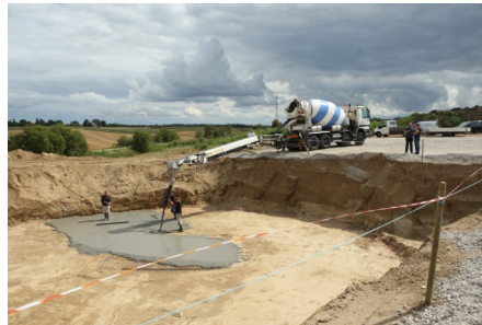
Støbning af renselag påbegyndt i Aalestrup
